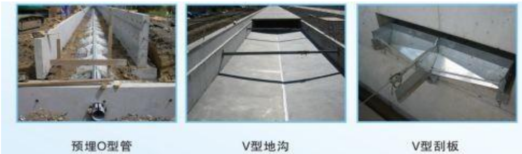
图 2.1-4 其他猪舍机械刮粪系统干清粪设备图
